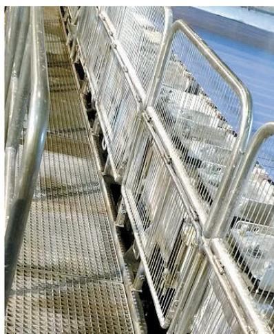
A imagem ao lado mostra o fechamento do guarda-corpo, com possibilidade de abertura com auxílio de ferramenta para as manutenções necessárias, permanecendo fixo nos períodos de produção normal.
